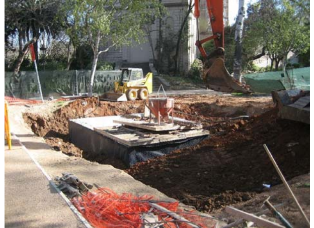
FOTO 18. Compactació de la terra aportada per tal de reblir l'estructura UE 110
