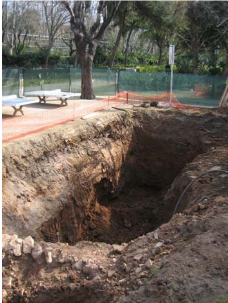
FOTO 5. Vista de l'excavació on podem observar el nivell de sorres que forma el substrat geològic de la zona
