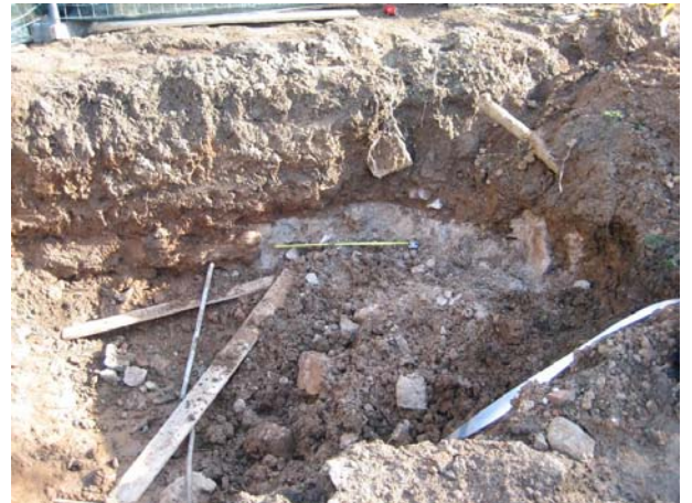
FOTO 2. Rasa inicial efectuada per l'excavadora. Podem veure part de l'estructura UE 110
