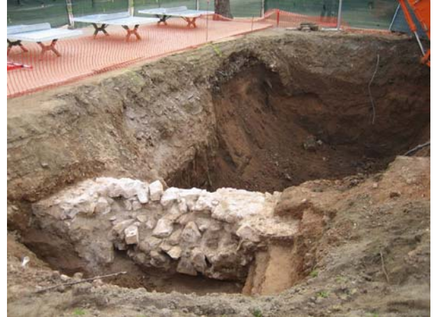
FOTO 10. Vista general de la zona d'excavació
