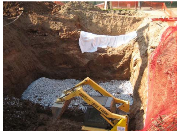
FOTO 12. Vista general de l'excavació amb l'estructura UE 110 al fons coberta amb geotèxtil
