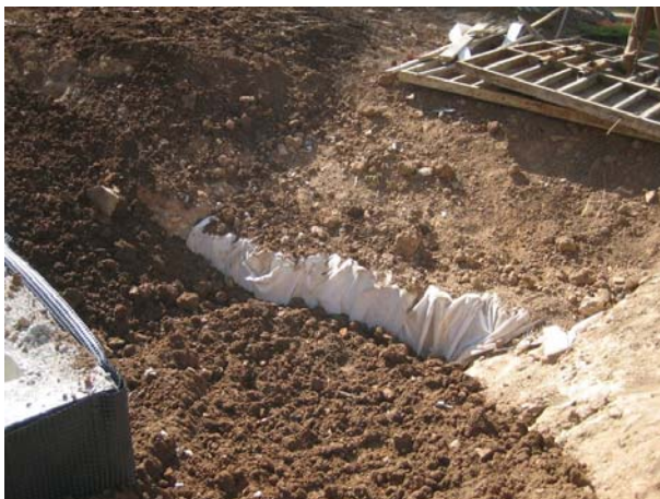
FOTO 15. Rebliment total de l'estructura UE 110 un cop finalitzada la construcció del dipòsit
