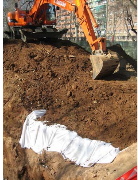
FOTO 14. Rebliment parcial de l'estructura UE 110
