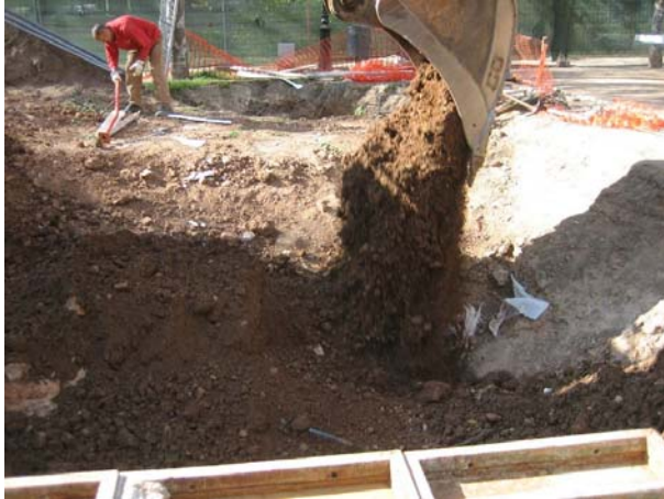
FOTO 17. Rebliment total de l'estructura UE 110
