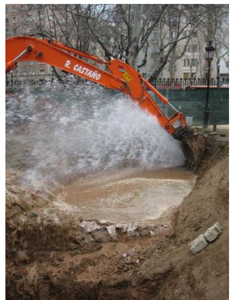
FOTO 4. Trencament d'una canonada d'aigua en el transcurs de l'excavació
