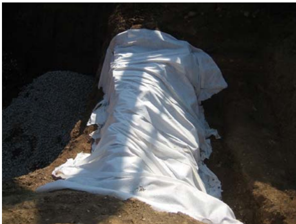
FOTO 11. Cobriment de l'estructura amb geotèxtil abans del seu rebliment parcial
