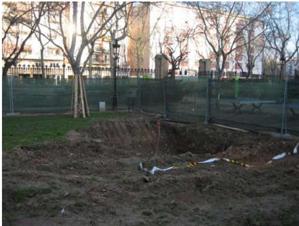
FOTO 1. Estat dels treballs en iniciar la nostra actuació
